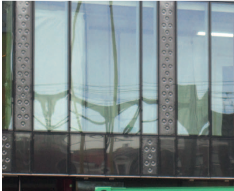
Figuur 6: 'Pillow werking' bij isolatieglas, 'tonvormige' vertekening.
