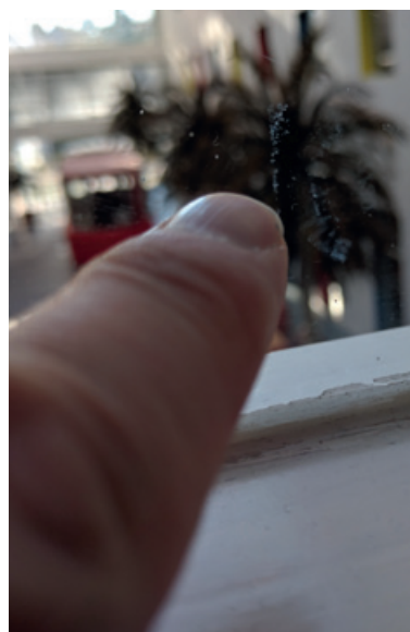
Soms is de stempel op het brandwerende glas niet of nauwelijks meer zichtbaar.
