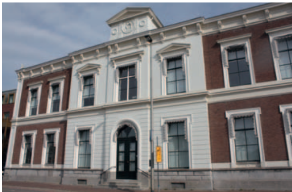
Het vervangen van het bestaande door nieuw glas is en blijft de meest duurzame keuze. Foto: Stolker Glas
