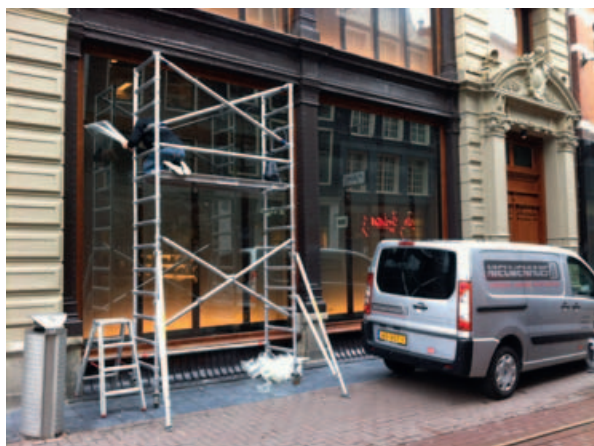
Het aanbrengen van anti-graffity film. Foto: Nieuwenhuis Raamfolie
